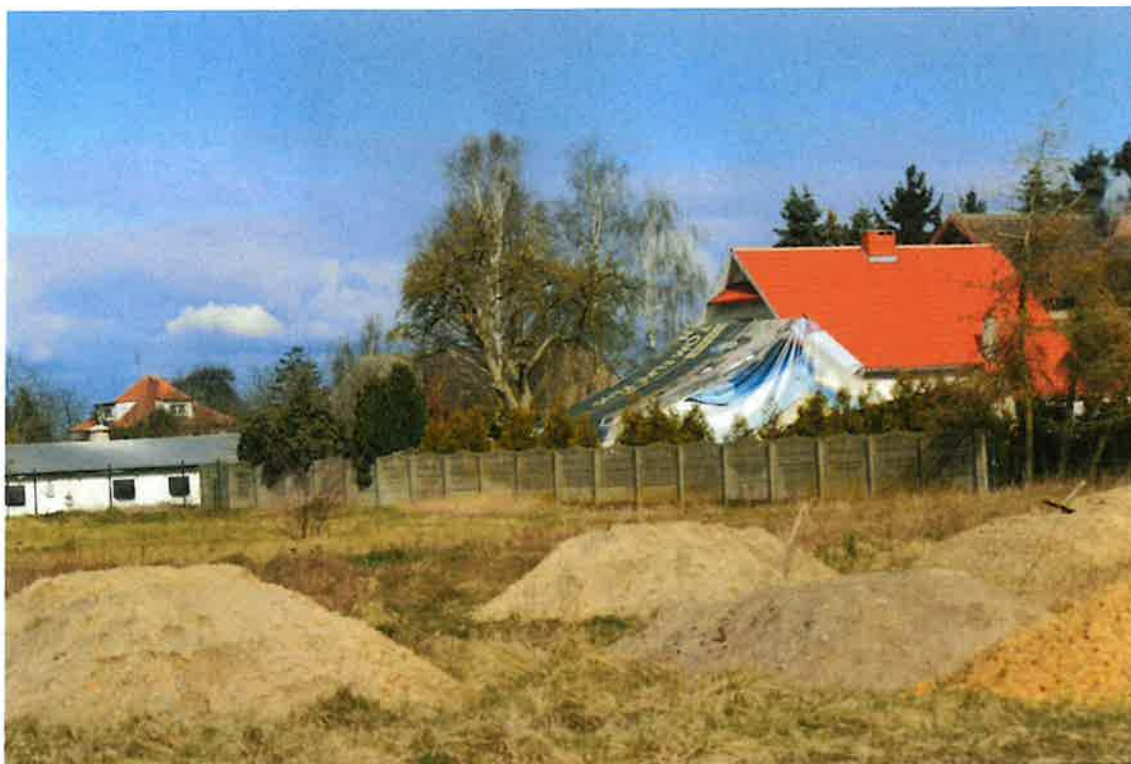
Fot. Widok na północną część terenu inwestycji
