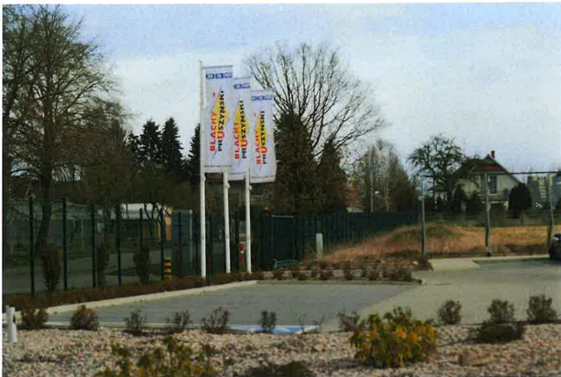
Fot. Widok na zachodnią część terenu inwestycji
