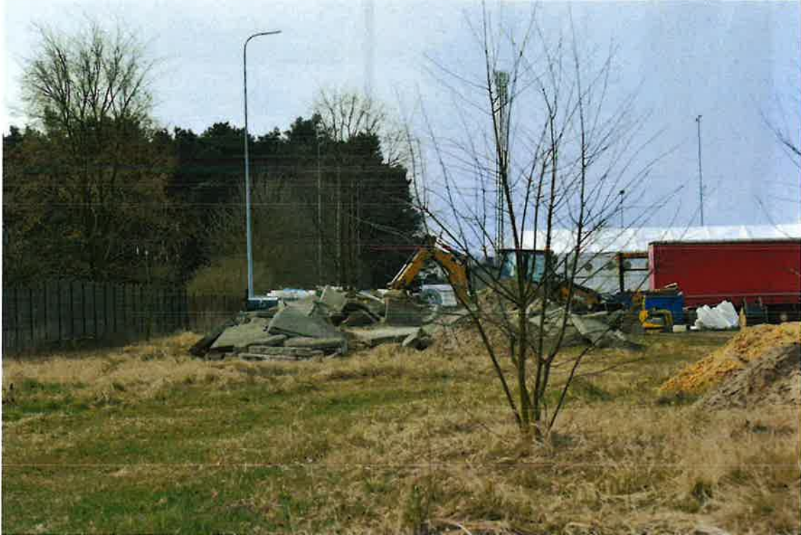
Fot. Widok na wschodnią część terenu inwestycji
