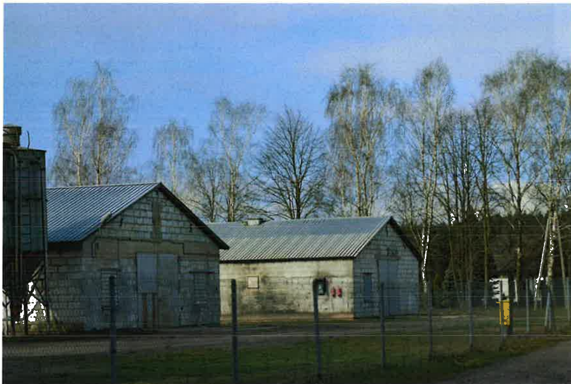
Fot. Widok na teren poza granicami, po stronie południowej terenu inwestycji
