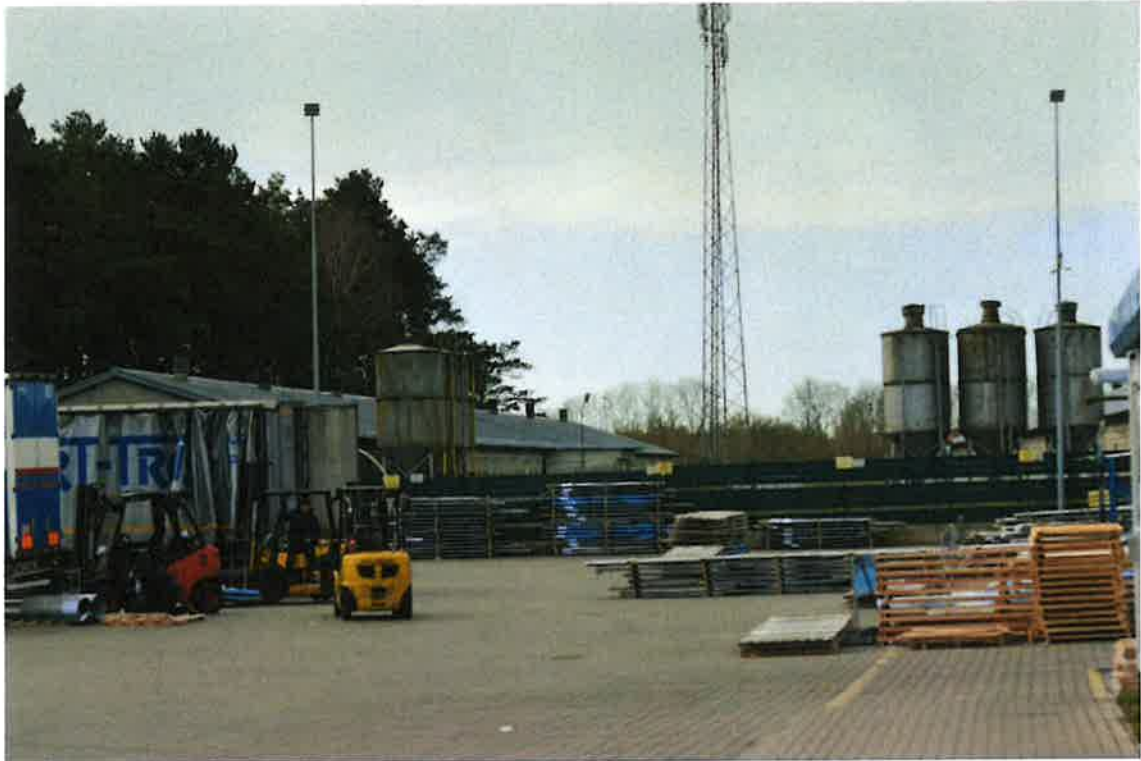
Fot. Widok na południową część terenu inwestycji
