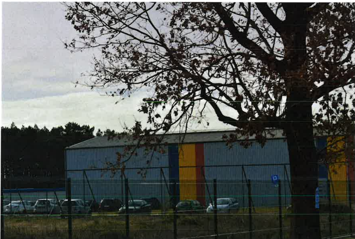
Fot. Widok na istniejącą halę produkcyjną na terenie inwestycji
