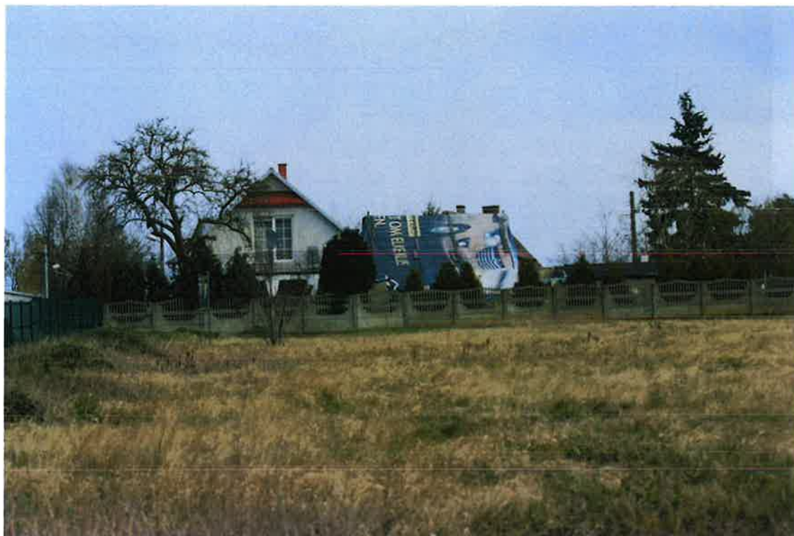
Fot. Widok na zachodnią część terenu inwestycji
