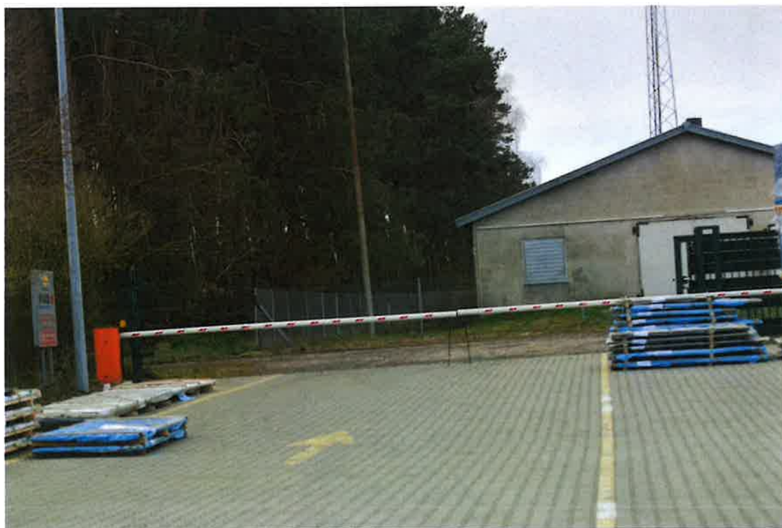
Fot. Widok na południową część terenu inwestycji i wjazd na teren
