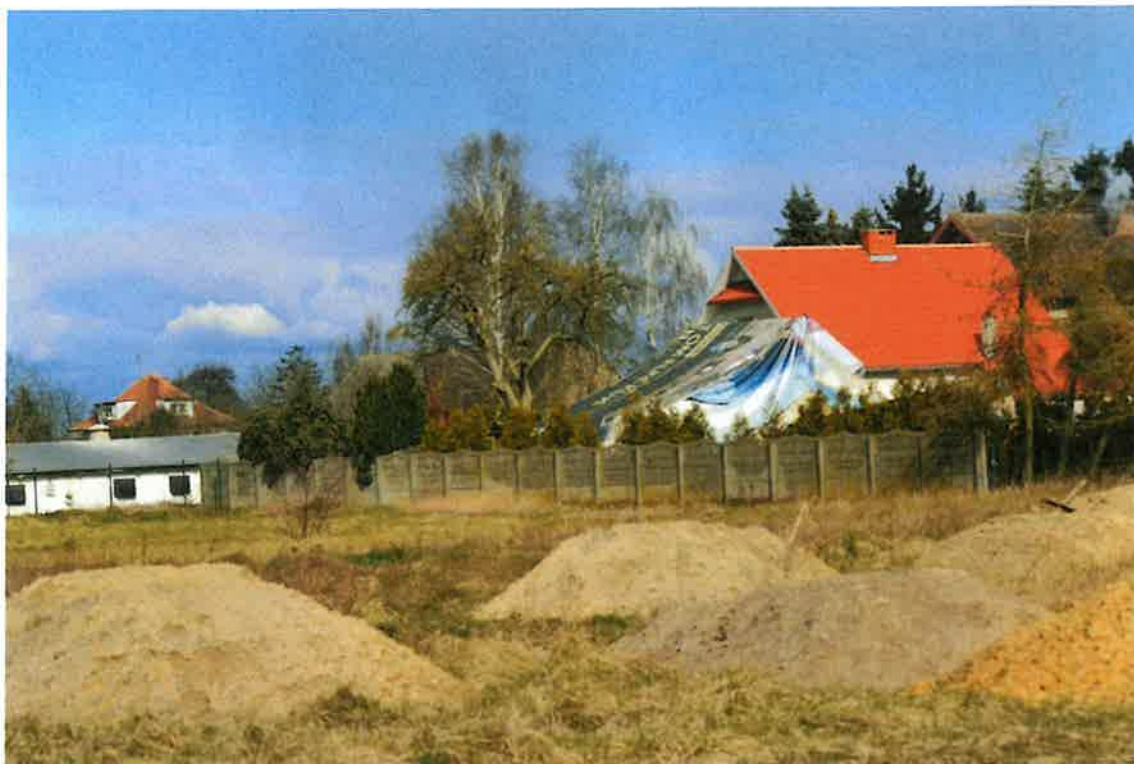
Fot. Widok na północną część terenu inwestycji
